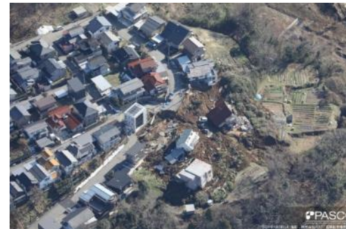
金沢市 田上新町付近 土砂の崩壊による住宅の倒壊
