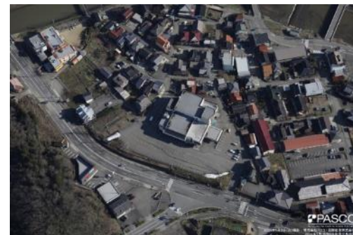
七尾市 小島町付近 駐車場の路面に亀裂
