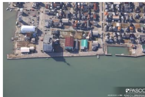
七尾市 つつじが浜付近 岸壁沿いに亀裂、泥が被った痕跡
