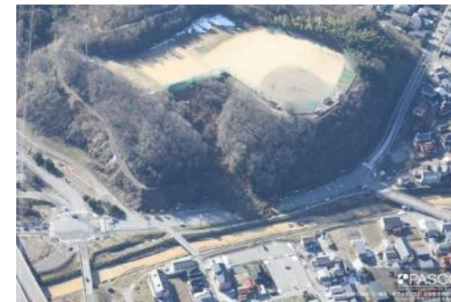
金沢市 御所町付近 土砂の流出により、道路が寸断
