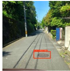
マンホール周辺
